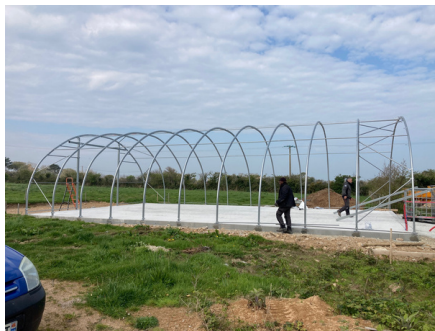
Installation d'un tunnel de stockage pour les véhicules communaux
