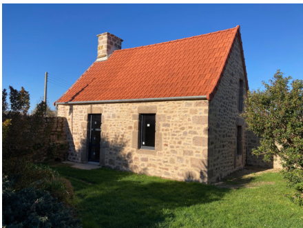
Restauration de la "petite boulangerie" destinée à l'accueil d'expositions ou la tenue de réunions d'associations
