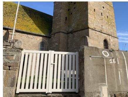
Pose de nouvelles barrières aux entrées des cimetières de Cosqueville et de Réthoville
