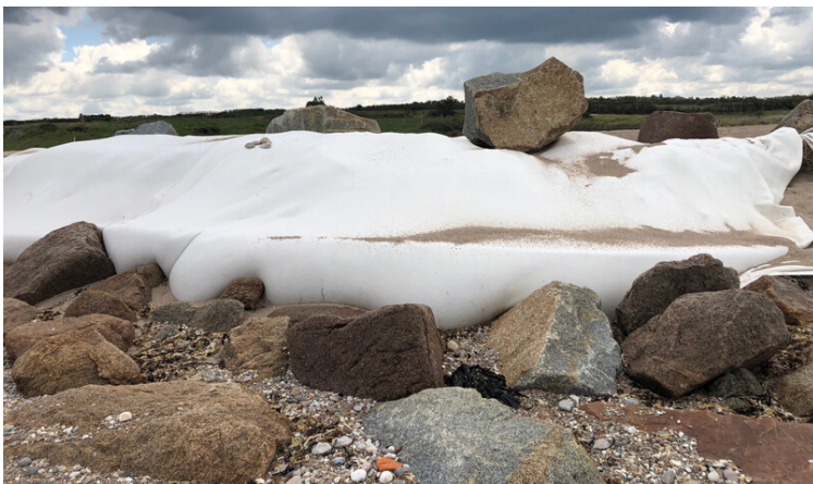
Photo de la décharge de Réthoville confinée - mai 2020
